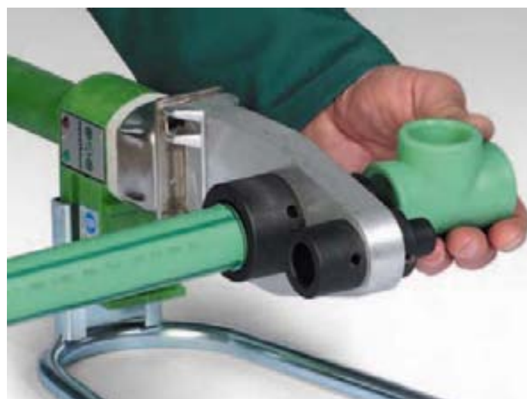
Нагряване на фасонните части
