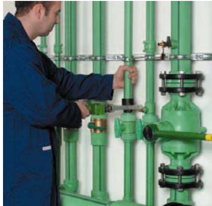
Изграждане на разпределител с fusiotherm® тръби със стъклофибър и сферичен кран
