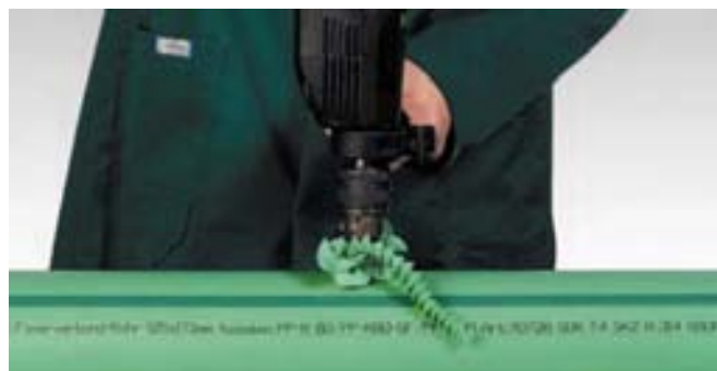
Пробиване на стената на тръбата
