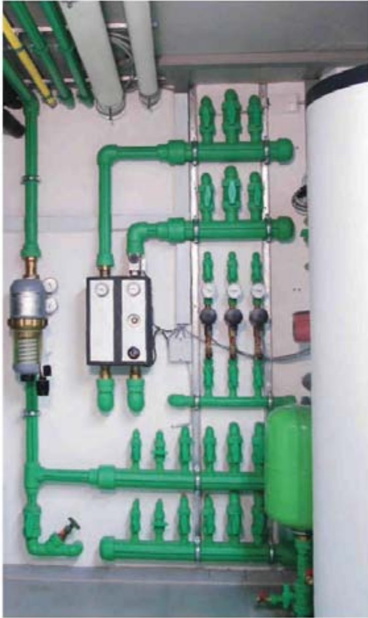
Изграждане на разпределители за водоснабдяване и отопление (жилищни сгради)
