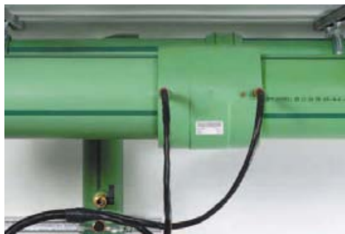
Заваръчният уред се поставя отвора на муфата. Заваръчният процес се стартира. Спазва се времето за охлаждане. Готово!
