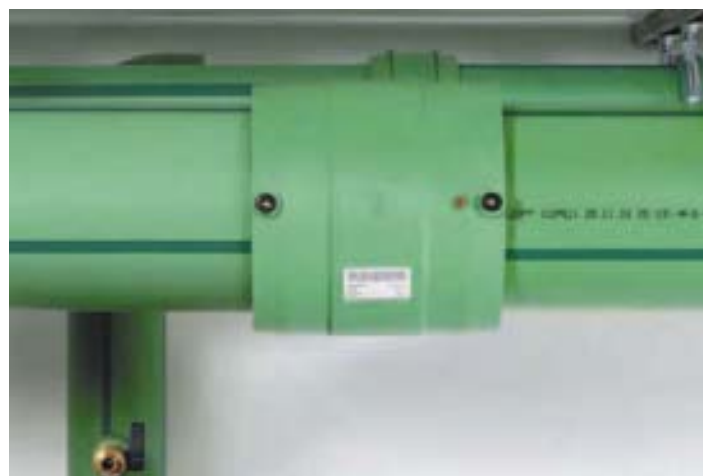
Напъхване на втората, също така обелена и почистена тръба в муфата
