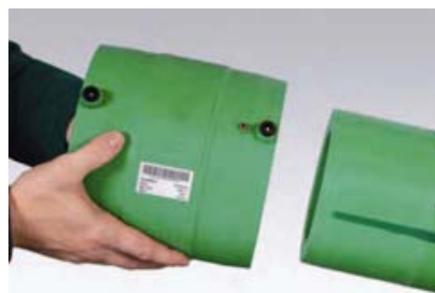
Напъхване на Е-муфите на края на тръбата
