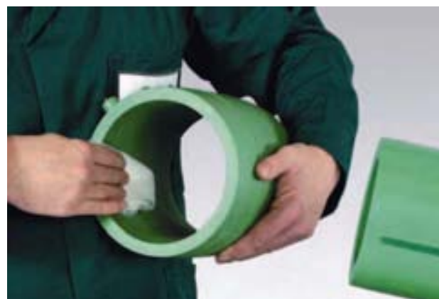
Тръбите за заваряване се режат, белят и се почистват основно
