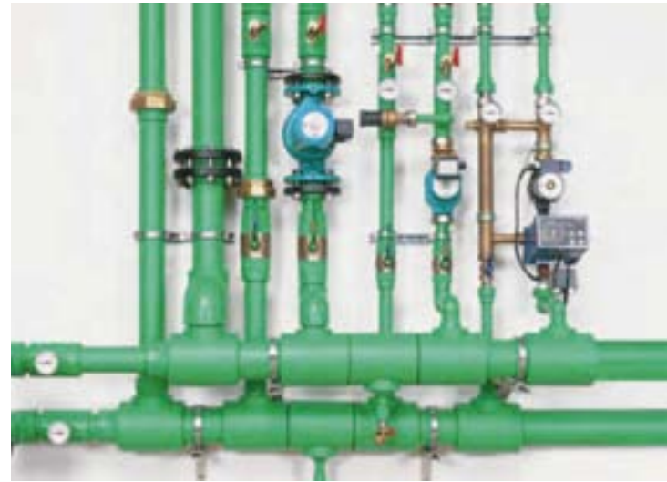
Изграждане на разпределители за отопление
